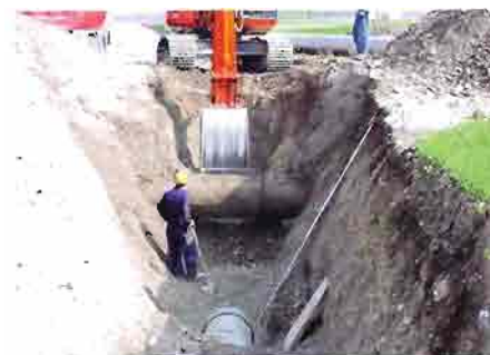
Lavori di conversione irrigua
