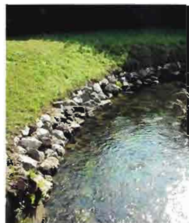
Bonifico idraulico: consolidamento di sponde con scogliera
